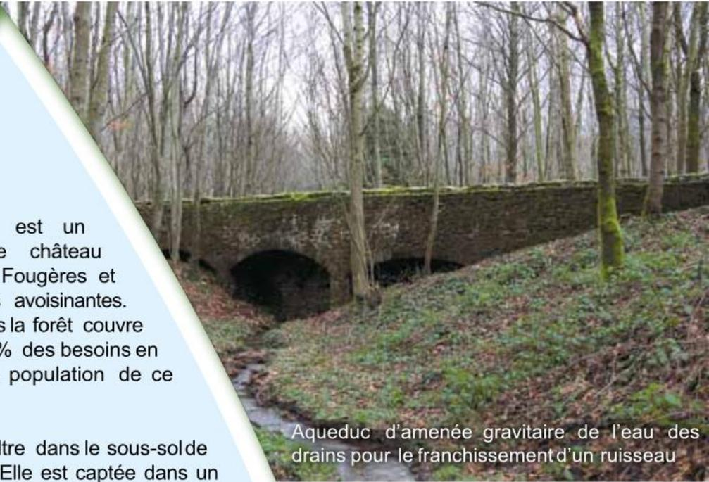
Aqueduc d'amenée gravitaire de l'eau des drains pour le franchissement d'un ruisseau
